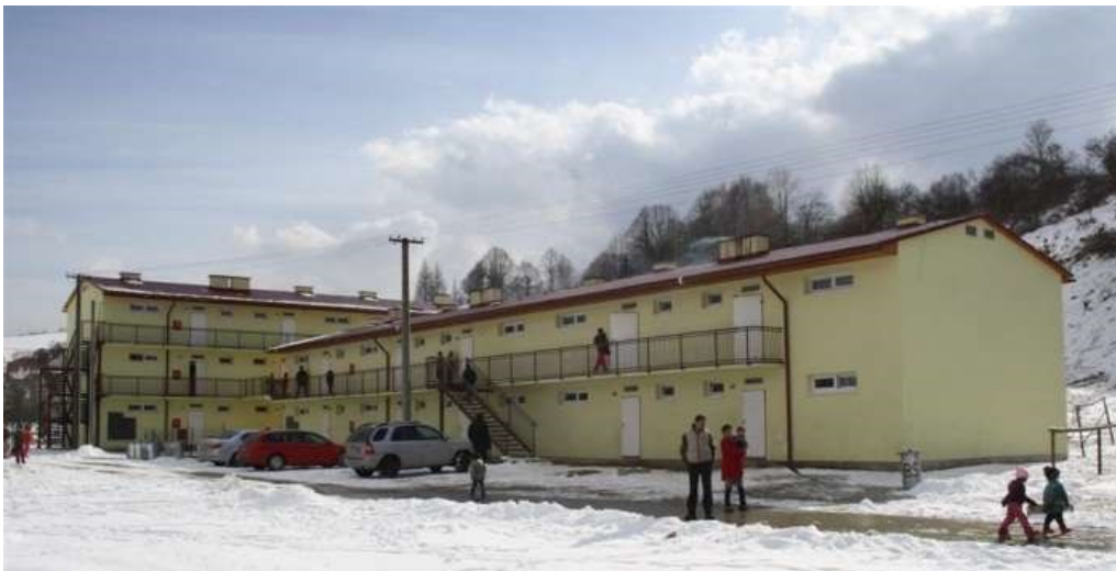
Obrázok 10 Bytový dom - nájomné byty NŠ, 19 b. j. (2. miesto v súťaži Progresívne, cenovo dostupné bývanie 2009)
